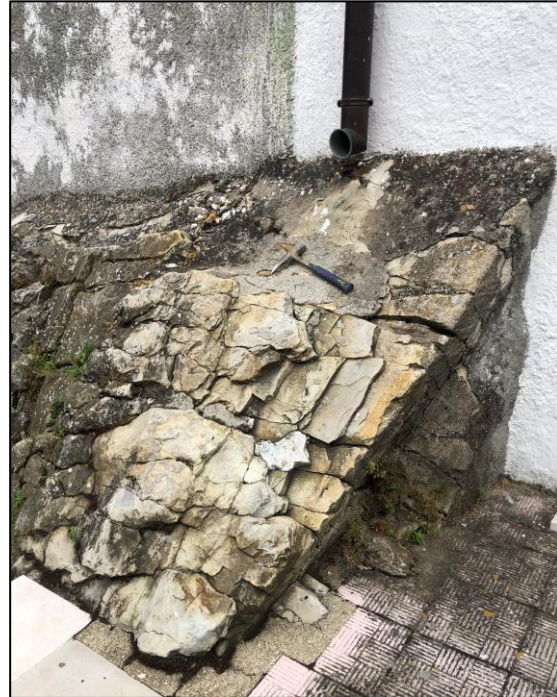
Figura 11. Vista generale (a sinistra) e dettaglio (a destra) dell'affioramento A10 in via Roma in prossimità della chiesa di Sta Caterina. Si noti la sottile stratificazione degli strati calcarenitici sottostanti l'edificio, fortemente inclinati su piano strada. Dettagli nel testo.
